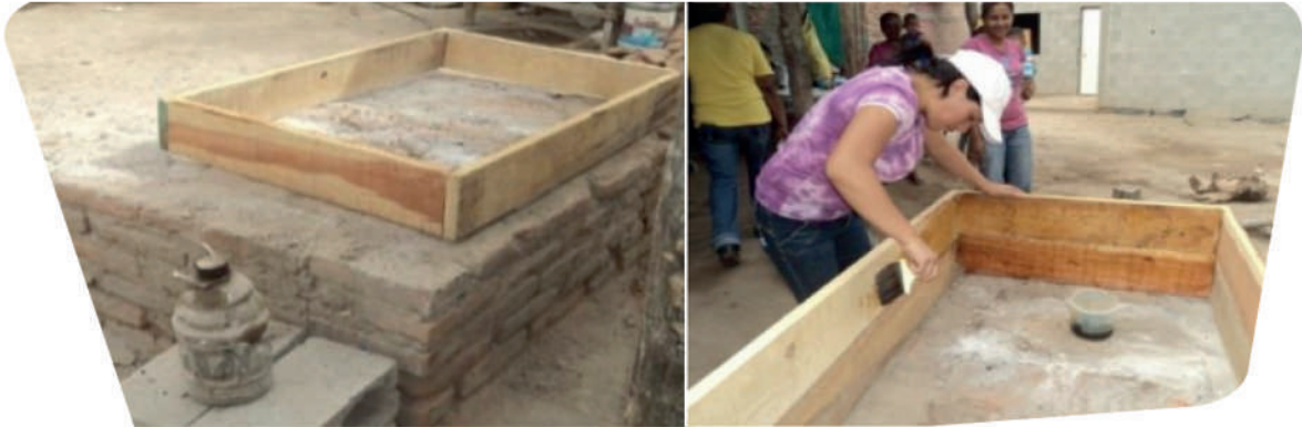
Armado de cajón o molde
