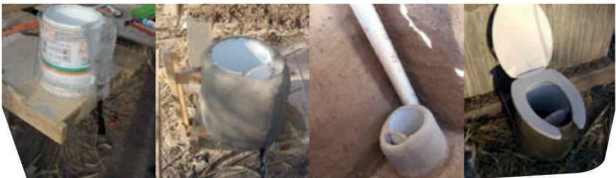
Proceso de construcción del eco-inodoro
